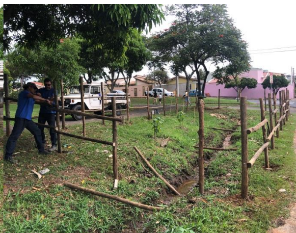
Isolamento da área
