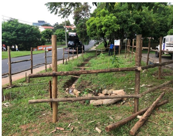
Isolamento da área
