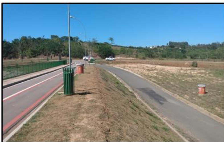
Vista geral da Ombreira esquerda a jusante
