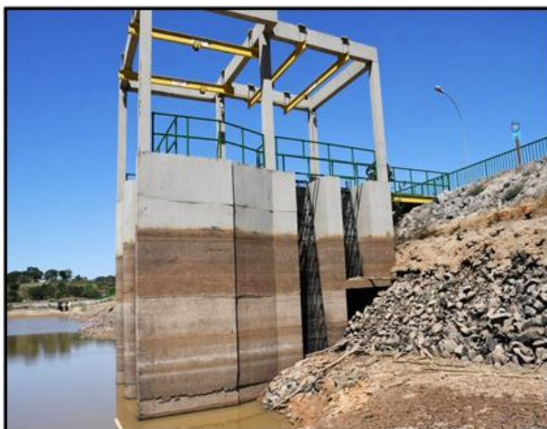
Vista Geral da estrutura da Tomada d'água
