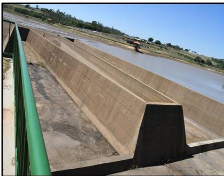
Vista geral da soleira do vertedouro labirinto.
