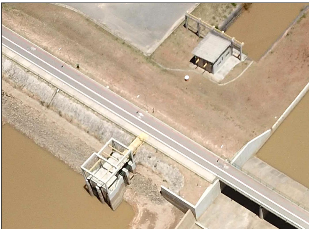
Figura 3 –Vista Geral da Estrutura Multifuncional (Tomada-d'água / Descarregador de Fundo).
