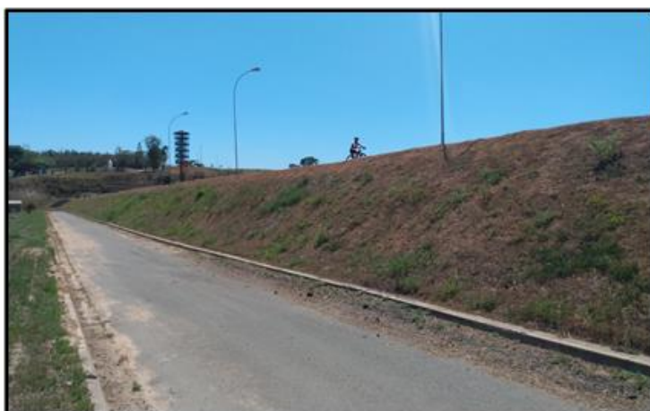
Vista Geral do talude de jusante
