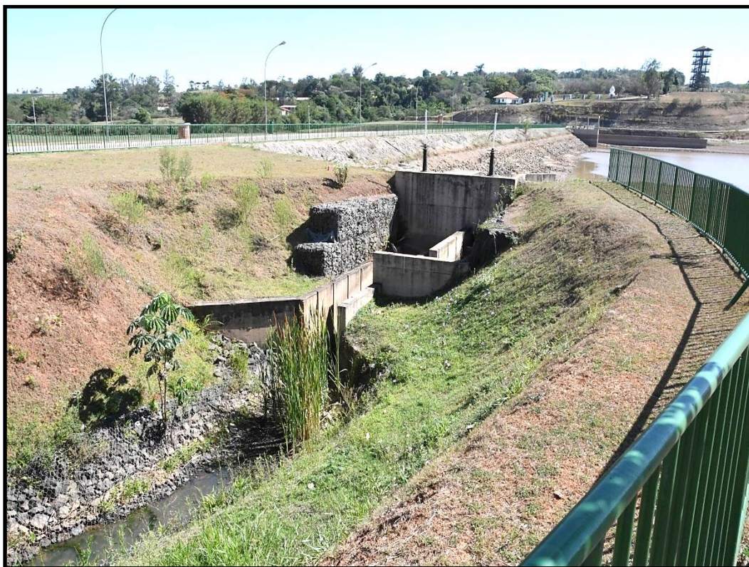
Figura 4 – Vista geral da Escada de Peixes.
