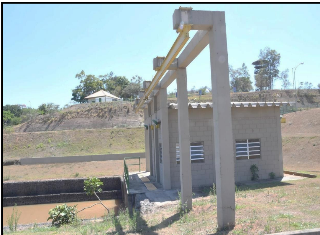
Figura 17 – Estrutura de saída – Vista Geral
