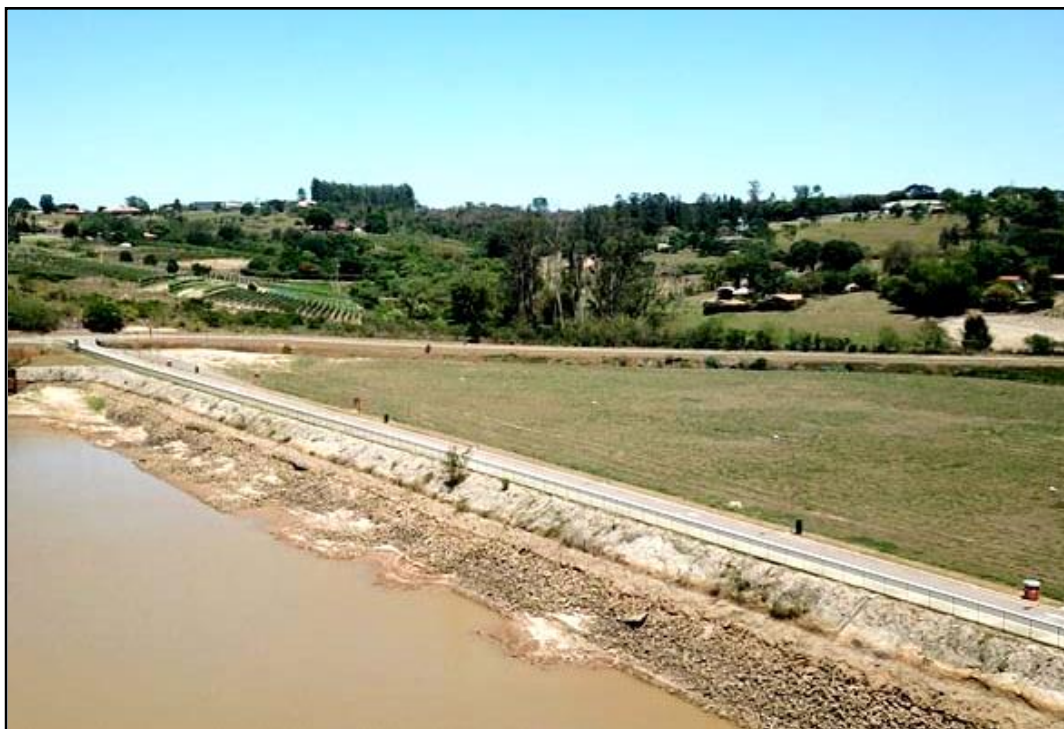
Figura 6 –Vista geral dos logas de escorregamento superficial do “rip-rap”.
