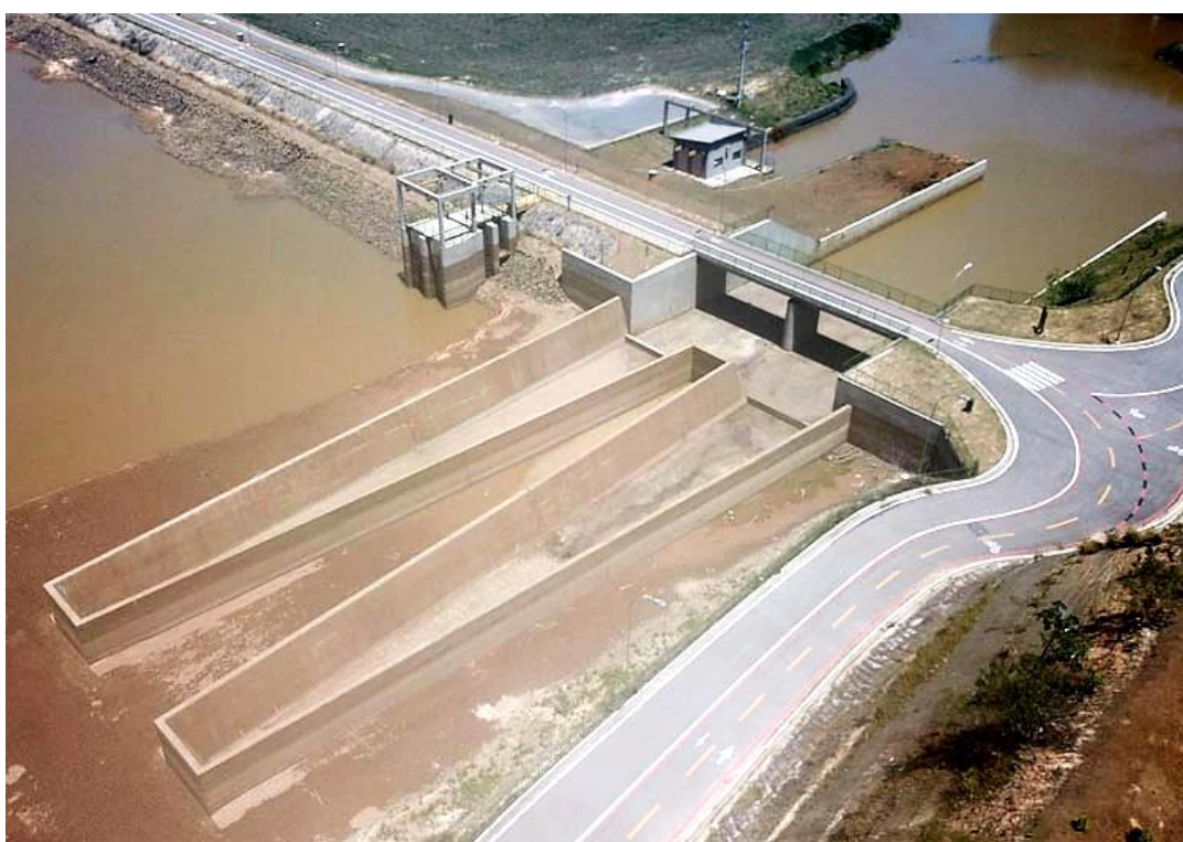
Figura 2 – Vista geral do Vertedouro a direita e da Estrutura Multifuncional a esquerda.
