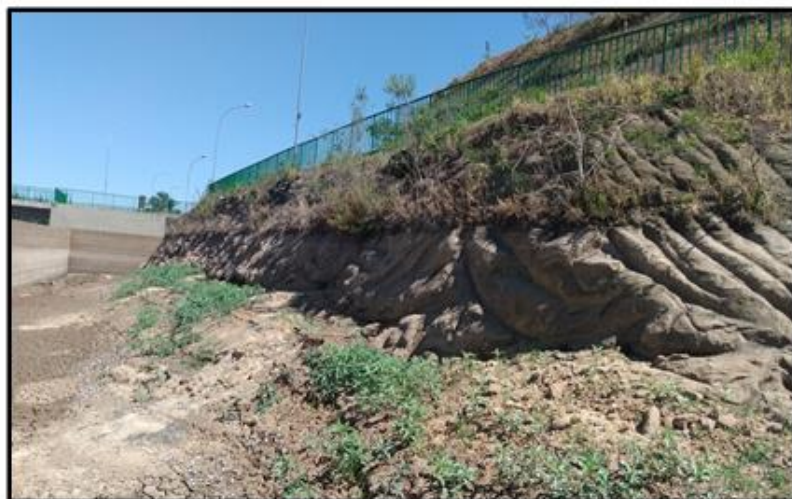
Vista geral da Ombreira direita à montante.
