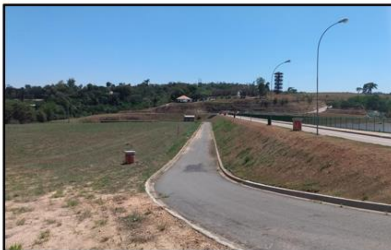
Vista geral da área a jusante da barragem
