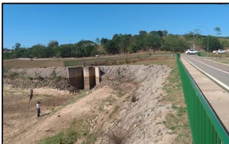
Vista geral da Ombreira esquerda à montante.
