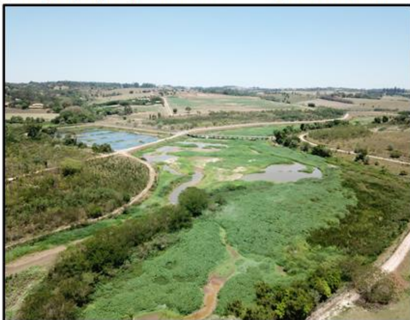
Trecho de montante do reservatório , com assoreamento e grande presença de vegetação
