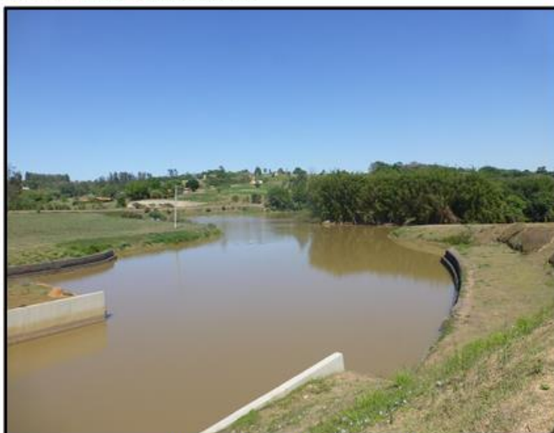
Vista geral do Canal de Restituição
