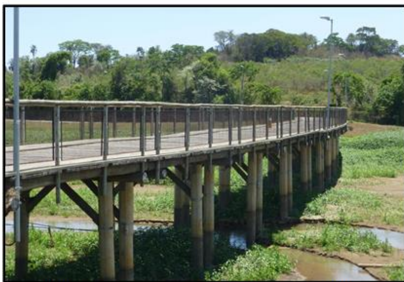
Vista da ponte sobre o trecho de montante do reservatório.
