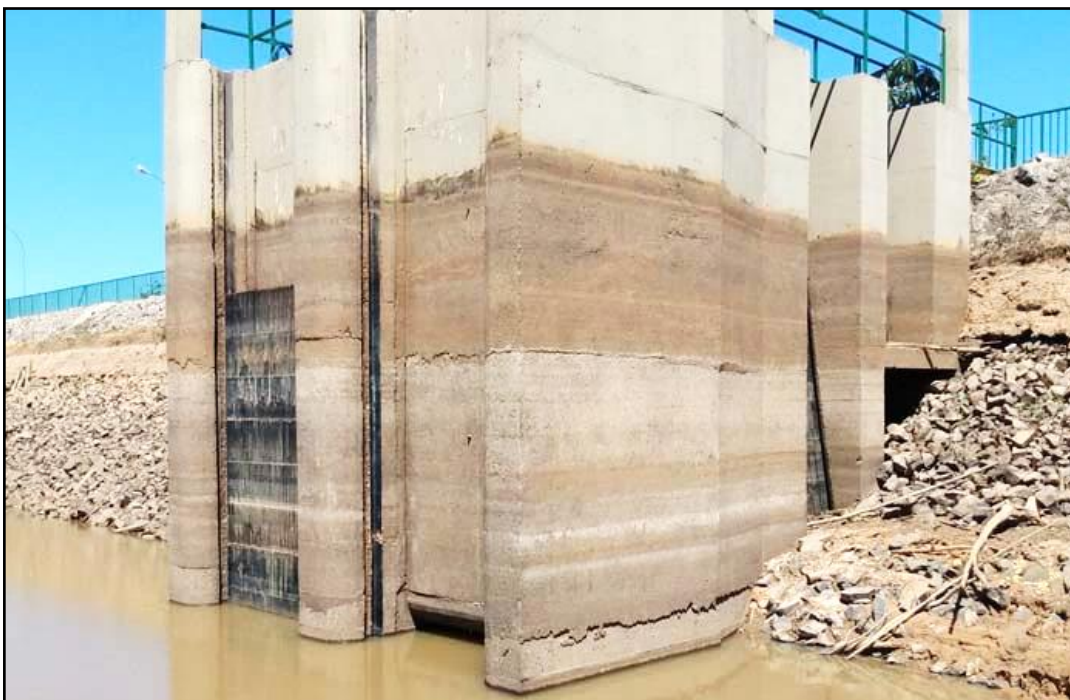
Figura 12 – Face normalmente submersa da tomada-d’água e bocas de entrada sem apresentar anomalias.
