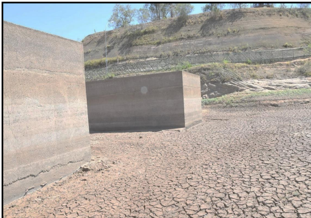
Figura 8 – Face de Montante do vertedouro labirinto, sem presença de anomalias.
