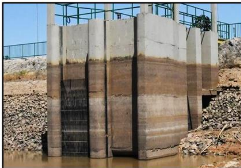
Vista geral das bocas de entrada forntias e laterais.
