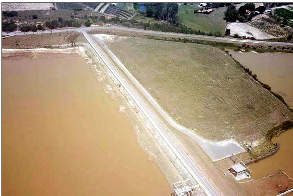
Figura 1 – Vista geral da Barragem e da área aterrada a jusante.
