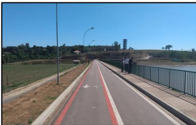
Vista geral da crista da barragem.
