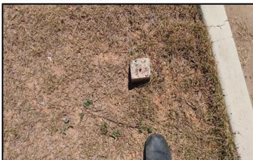
Marco topográfico danificado
