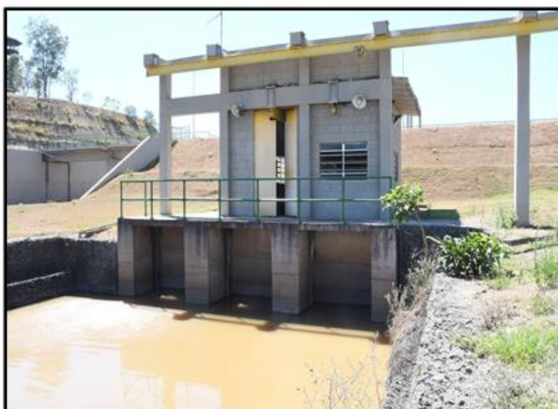
Vista geral da estrutura de saída e da casa de válvulas de jusante.
