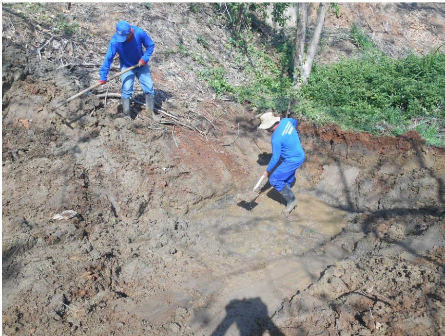
Desobstrução manual da nascente (Set 2017)
