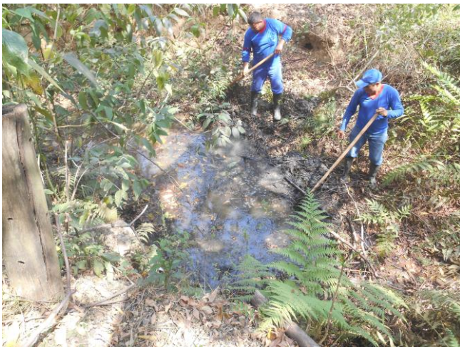
Desobstrução da nascente (Set 2017)
