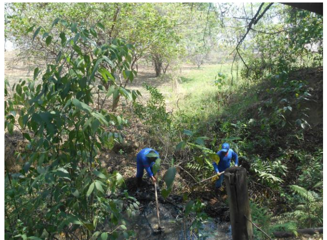
Limpeza manual da nascente ( Set 2017)
