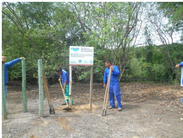
Instalação da placa do programa (Nov 2017)
